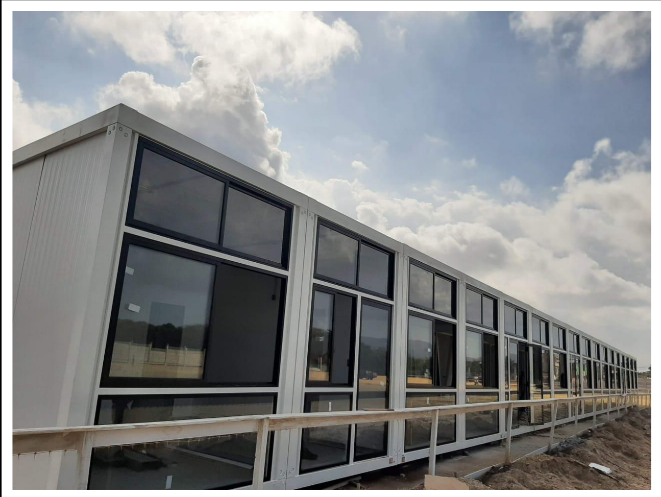
MÓDULO DOS ATLETAS INSTALAÇÃO DE ESQUADRIAS DE ALUMÍNIO
