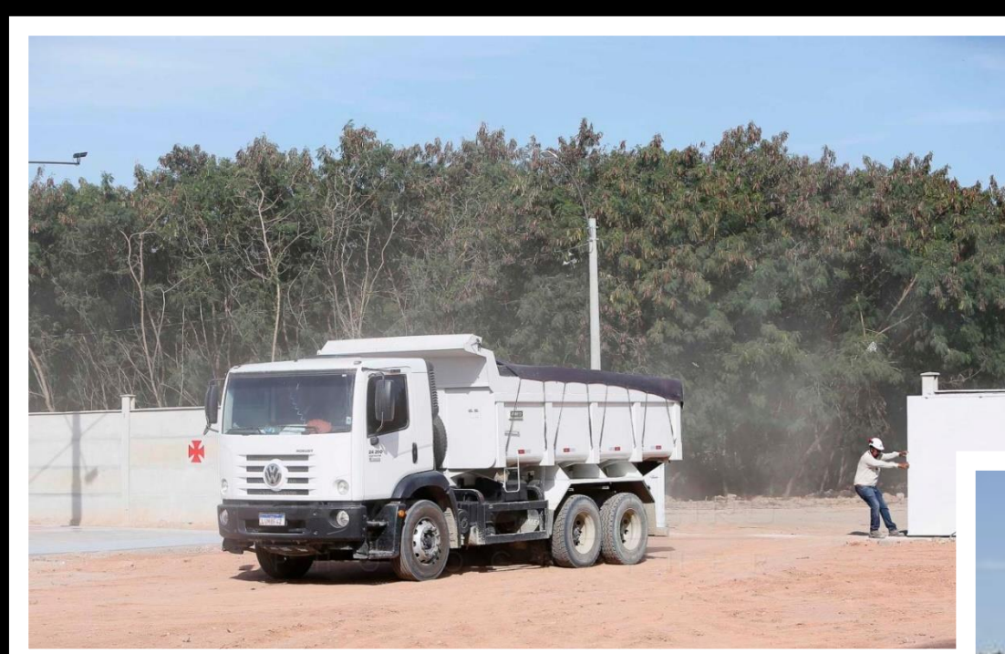
RECEBIMENTO DE AREIA PARA SEGUNDA FASE DA DRENAGEM
