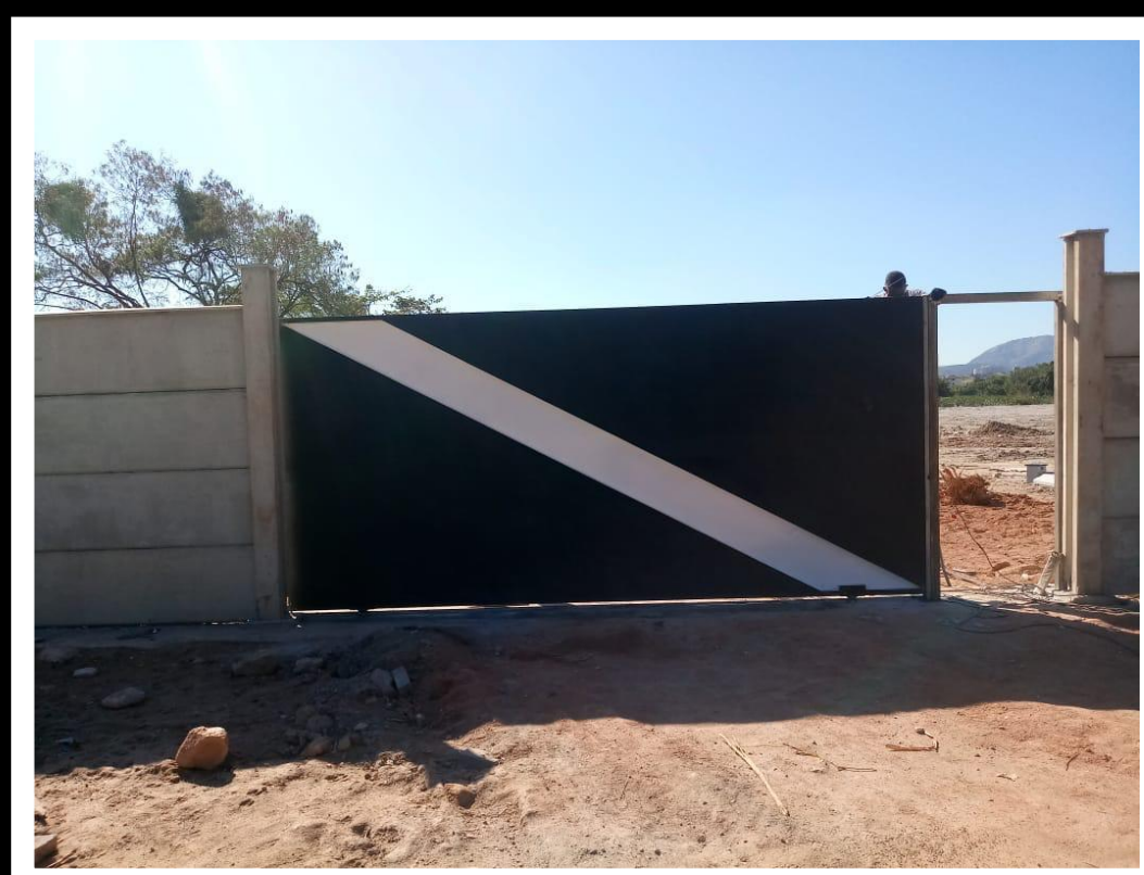
PORTÃO DE VEÍCULOS
