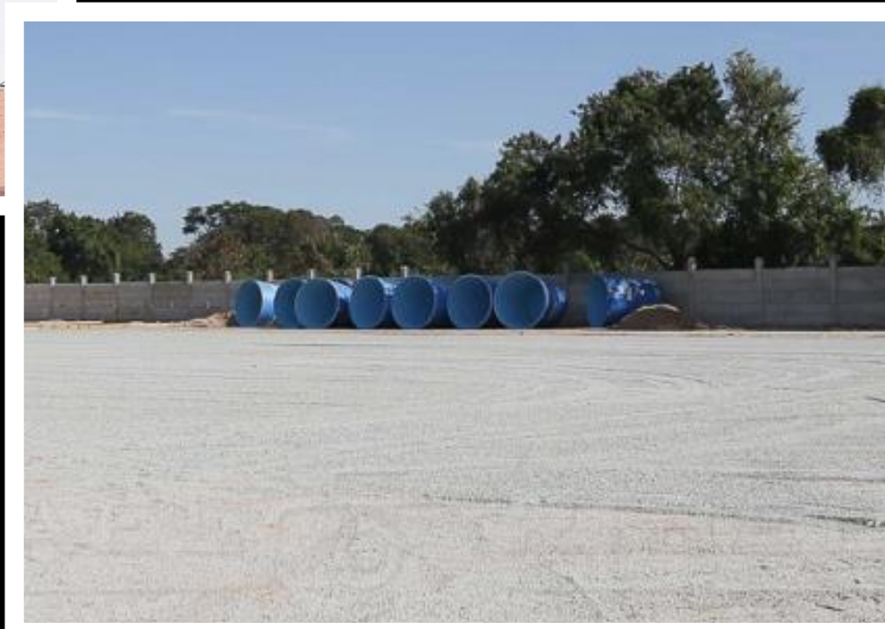
RESERVATÓRIOS DE ÁGUA
