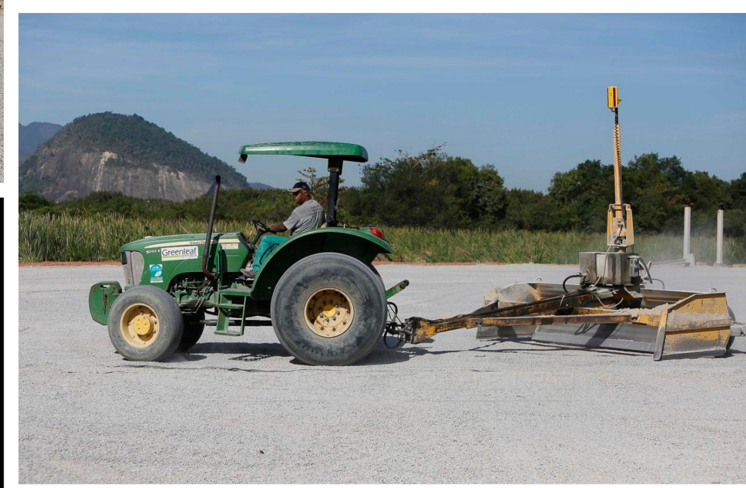
NIVELAMENTO A LASER DA BRITA
