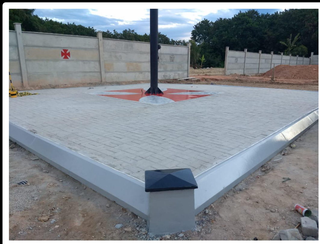
PRAÇA DO MASTRO
