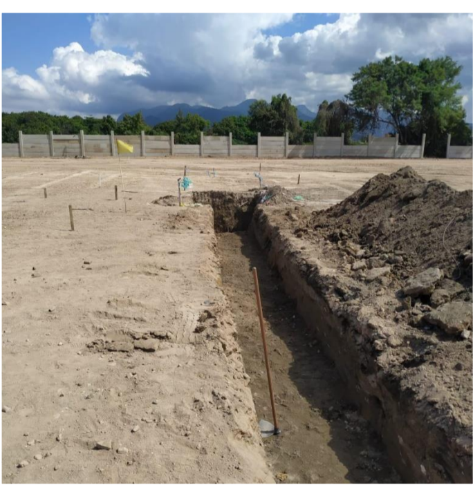
EXECUÇÃO DA CAIXA DE DRENAGEM DOS CAMPOS
