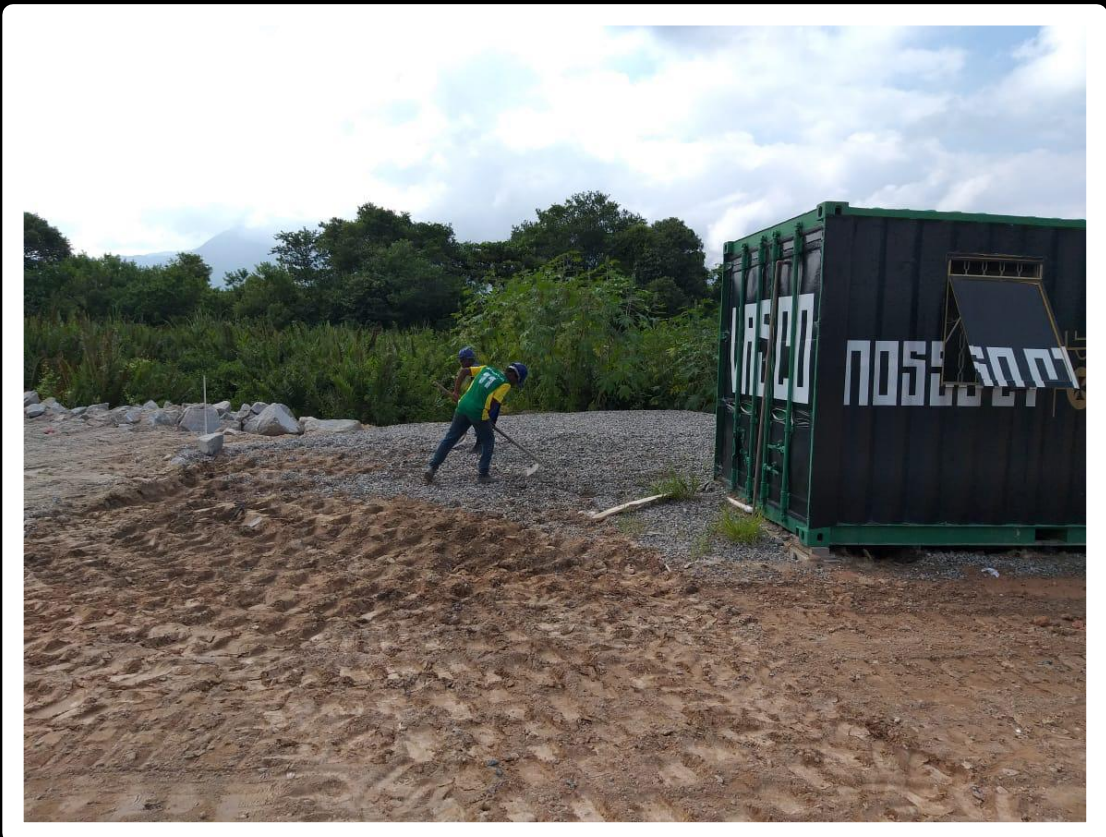
NIVELAMENTO DA DRENAGEM DO GRAMADO
