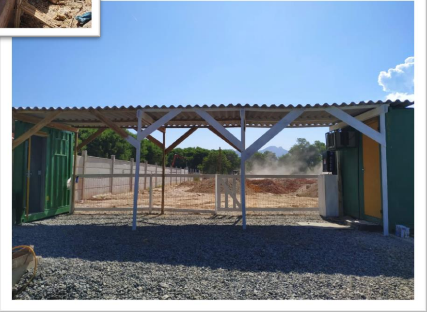
Canteiro de obras
