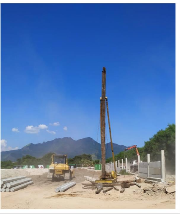
Cravação de estacas do bloco de fundação do mastro
