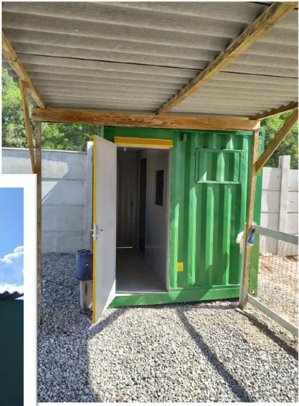
Canteiro de obras
