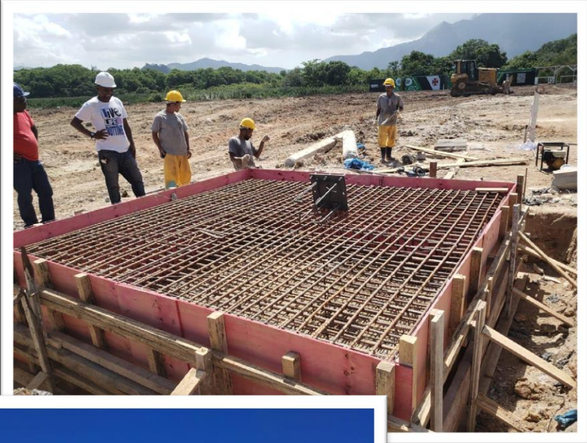
Bloco de fundação do mastro
